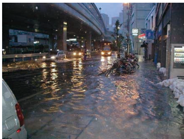
▲ 平成16年台風第18号(国道2号海岸通5丁目付近の状況)
